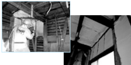
従来のグラスウールの断熱材よりも、はるかに高気密・高断熱の発泡断熱材「アイシネン」を採用 フロンガス無使用で水の発泡により100倍に広がるわずかな隙間も断熱します 結露防止、防音効果、難燃性、そして光熱費削減に効果あり
