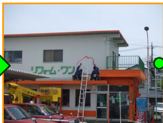
⑪事務所壁看板設置
