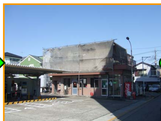
①養生及び高圧洗浄
