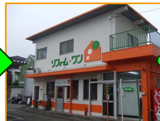
⑫事務所壁看板設置 入り口看板設置
